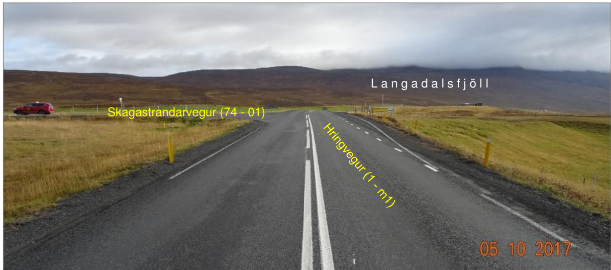
Mynd 2.2.4. Vegamót Hringvegur og Skagastrandarvegur, austan Blönduóss. Horft í átt að Langadal (ljósmynd: Sóley Jónasdóttir, 2017).
